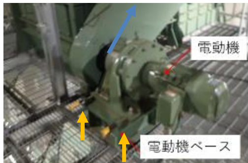
電動機ベースの外力負荷状態
