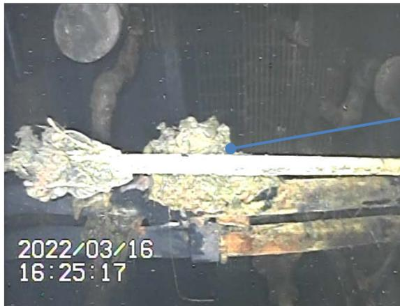
気中の配管に付着した堆積物
