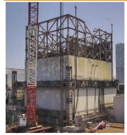
<1号機 残置カバー解体中の様子>
