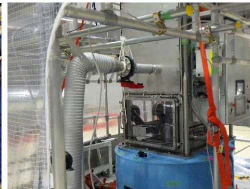
換気ユニットの換気風量確認
