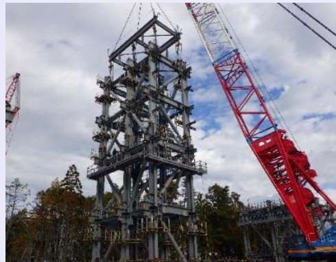
<鉄骨ユニット接合確認状況(2022年11月5日)>
