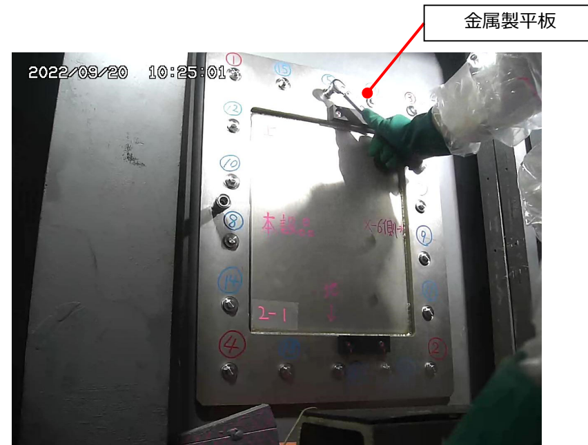
金属製平板取付け作業
