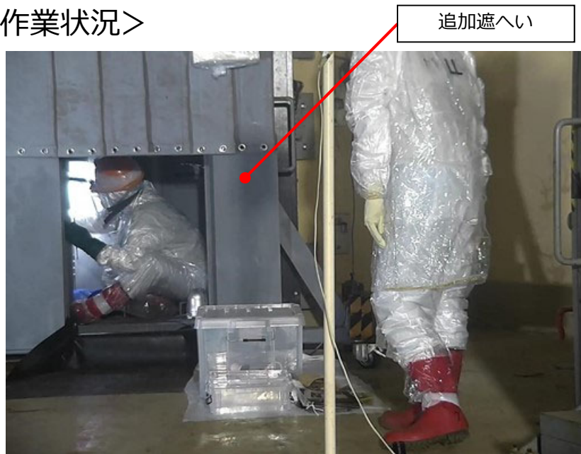
箱型ゴム取外し作業
