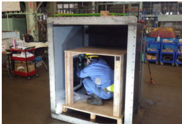
金属板取付け
