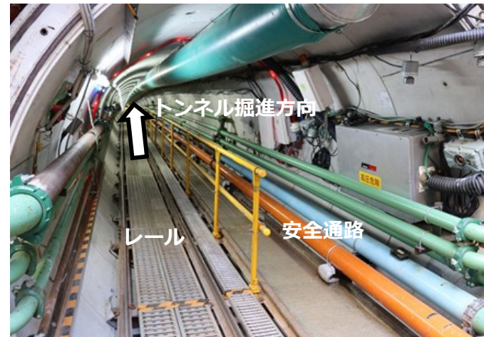
トンネル内部安全設備の整備状況
