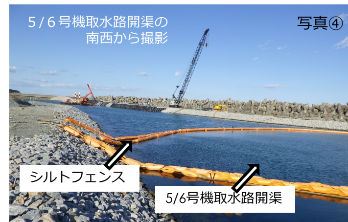
5・6号機海側工事エリアの状況
