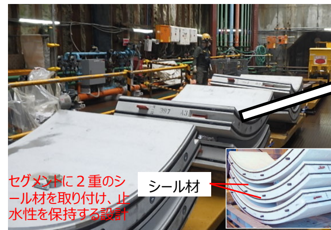
セグメント搬入状況
