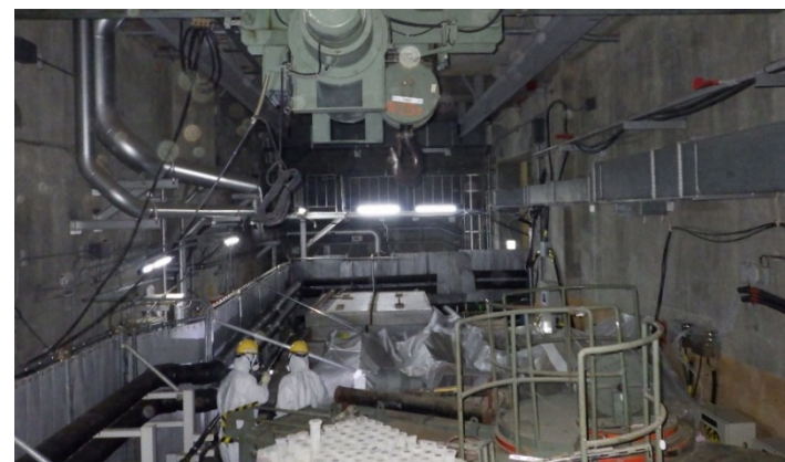
ハッチ付近 (ROV投入箇所)
