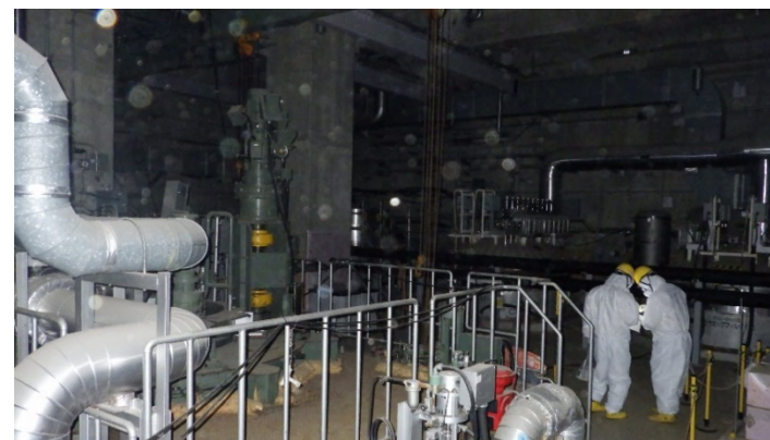
建屋西側付近 (容器搬出入箇所)
