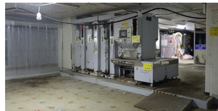
補機設置予定エリア付近
