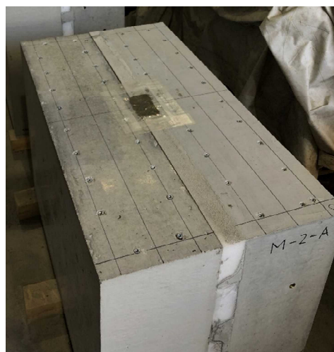
手順 5 : 止水材 (モルタル) 注入完了
