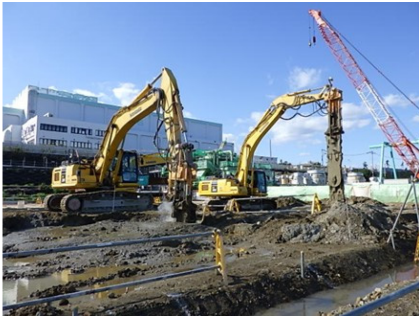
地盤改良の状況
