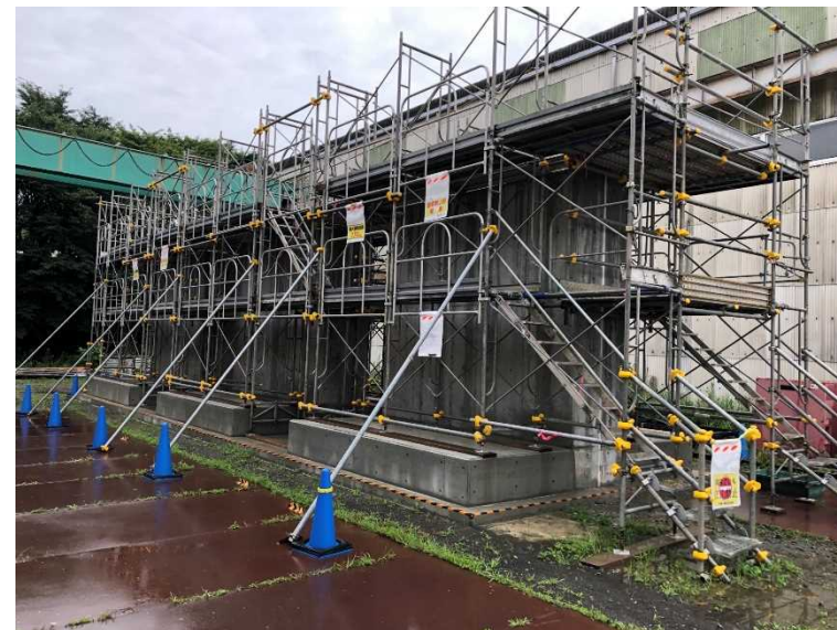
写真1. 試験体構築完了
