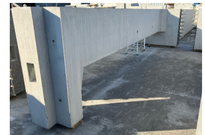
上流水槽隔壁
