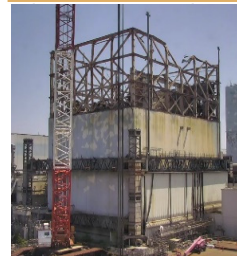
<1号機 残置カバー解体中の様子>
