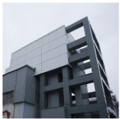
<4号機 燃料取り出し用カバー>
