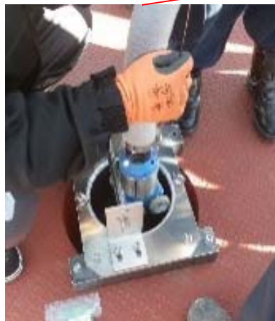
配管内アクセス装置挿入(3階)
