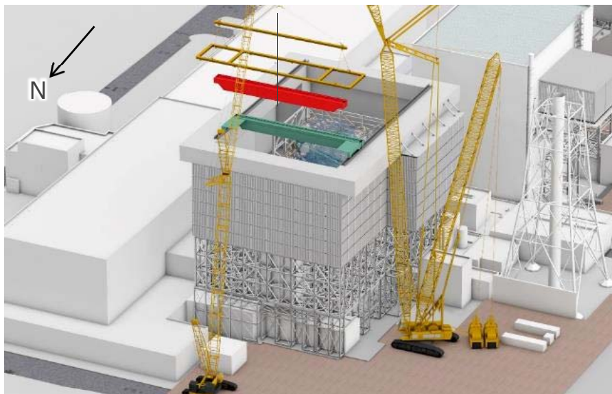
ガレキ撤去用天井クレーン設置中
