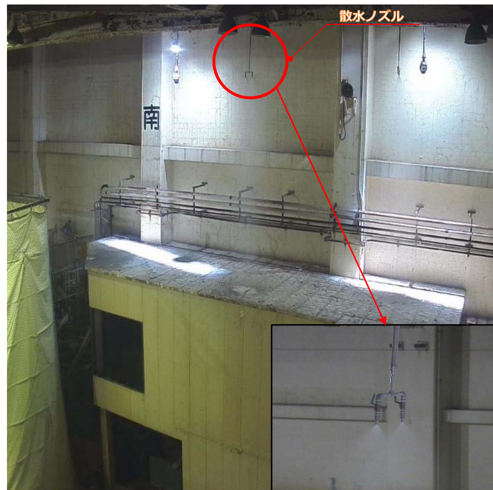
散水設備設置写真（ダスト飛散対策）
