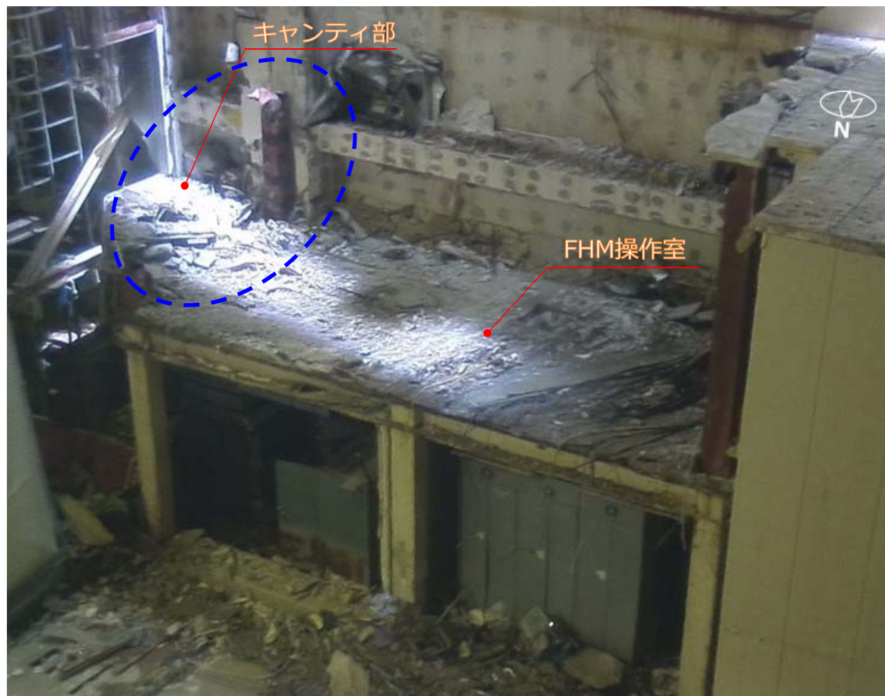
撤去作業状況 (9月22日撮影)
