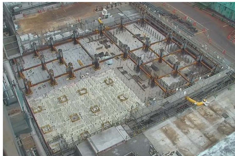
2号機原子炉建屋南側ヤード全景 (撮影：2022.9.10)
