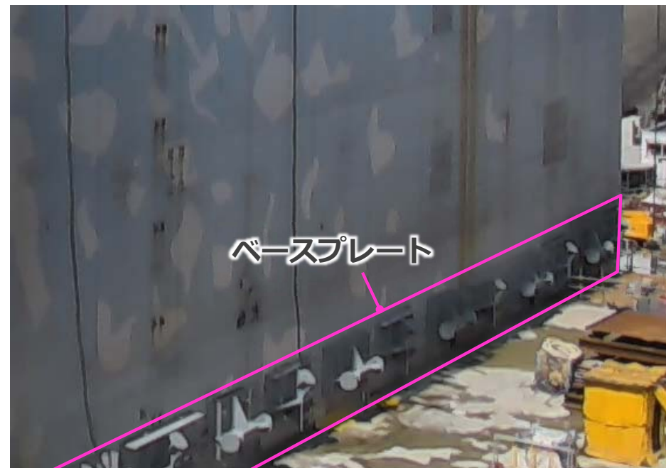
ベースプレート設置状況（東面） (撮影：2022年9月21日)
