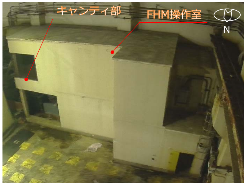
FHM操作室撤去前
