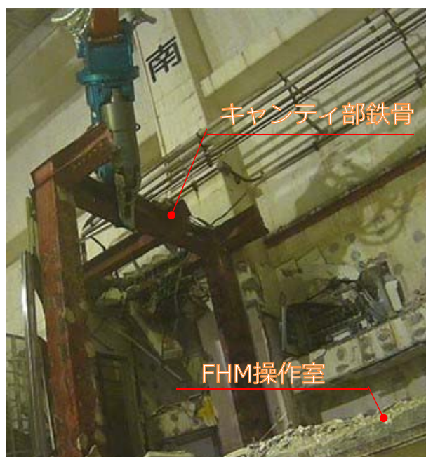
部鉄骨撤去作業時の状況
