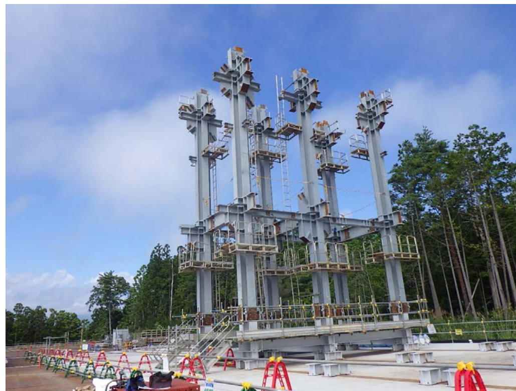
鉄骨地組作業状況（撮影：2022.9.7）
