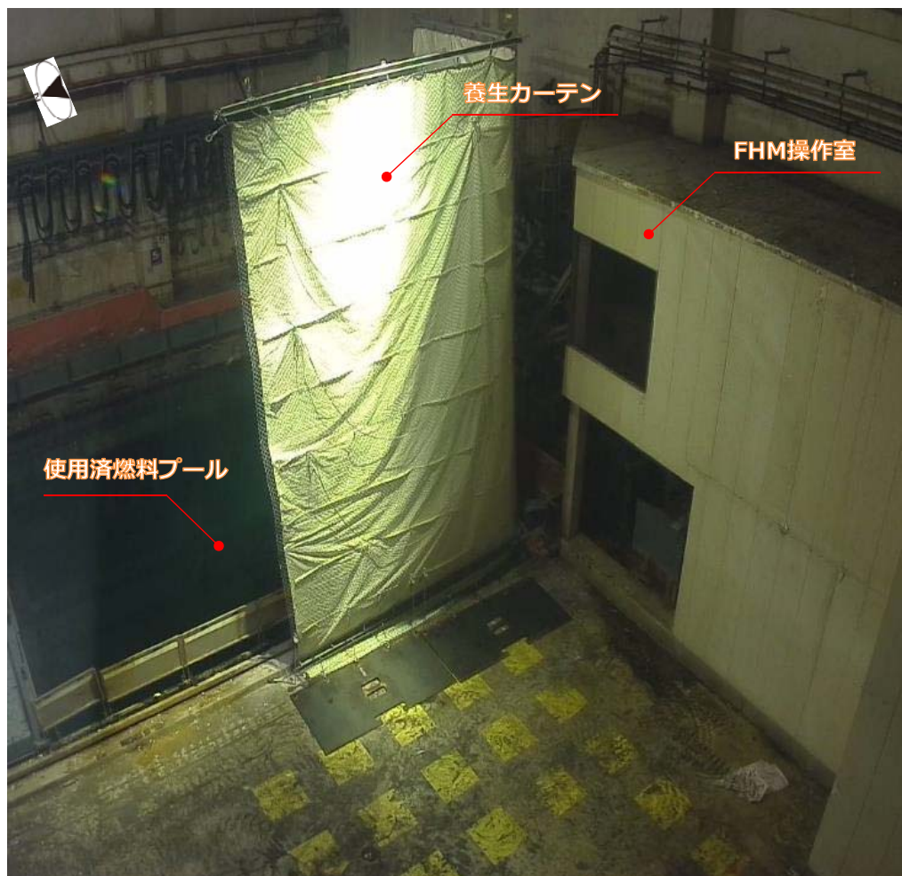
SFP養生カーテン設置写真（瓦礫飛散対策）
