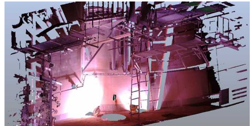
2階シェル壁東面（点群データ）
