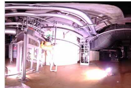
3階シェル壁北東面（写真）
