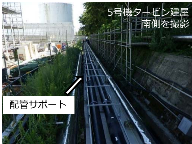
移送配管サポート設置の状況
