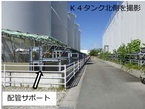
循環配管サポート設置の状況
