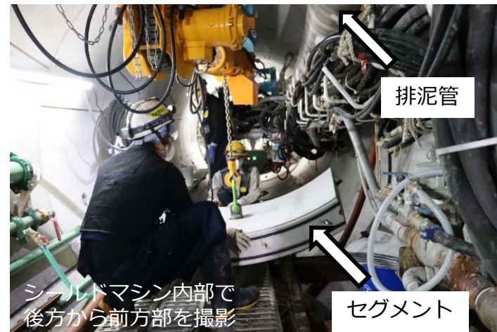
セグメント搬送状況（トンネル内）
