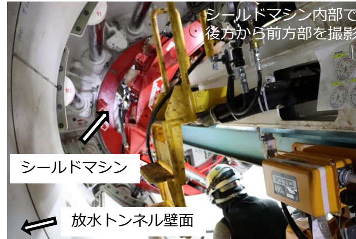
シールドマシン掘進作業の状況
