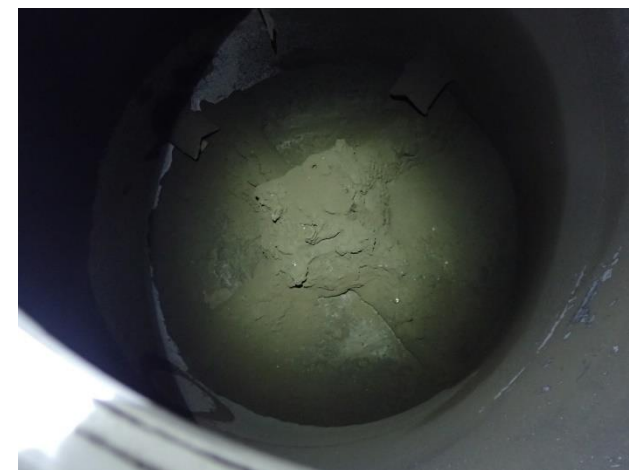
飛灰ホッパ内部の様子
