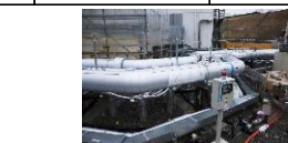
陸側遮水壁ライン（冷媒）循環配管
