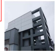
<4号機 燃料取り出し用カバー>
