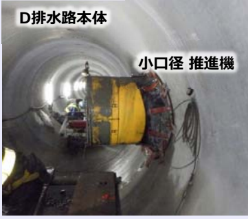
<D排水路の施工状況> (小口径推進工事の様子)
