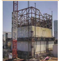
<1号機 残置カバー解体中の様子>
