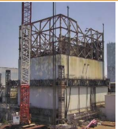
<1号機 残置カバー解体中の様子>
