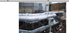
陸側遮水壁ライン（冷側）循環配管
