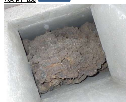
B: 主灰取出ボックス下部シュート内部(左:清掃前、右:清掃後)
