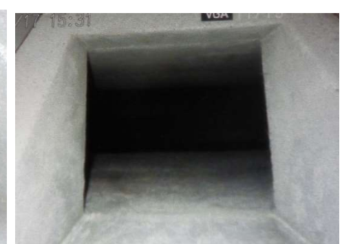
B: 主灰取出ボックス下部シュート内部(左:清掃前、右:清掃後)
