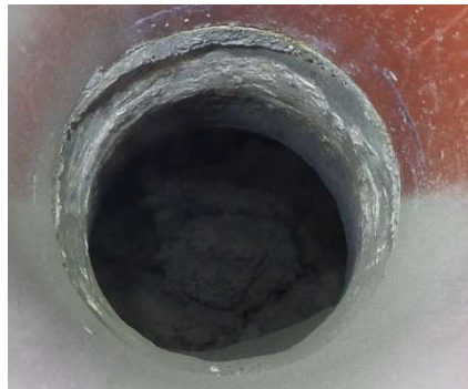
A: ストーカ内部(覗き窓から撮影)
