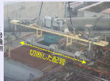
＜配管切断作業の様子＞
