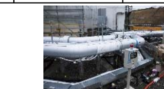
陸側遮水壁ライン（冷側）循環配管
