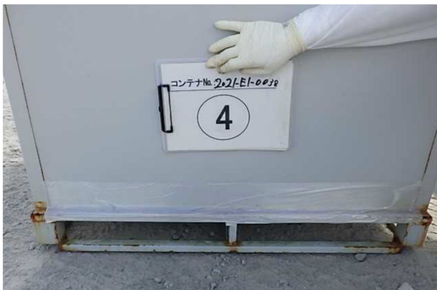
補修済みコンテナ
