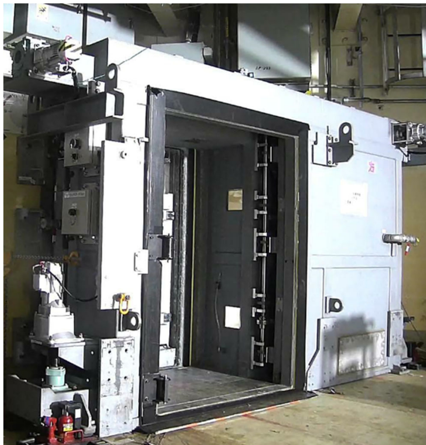
隔離部屋②の設置状況
