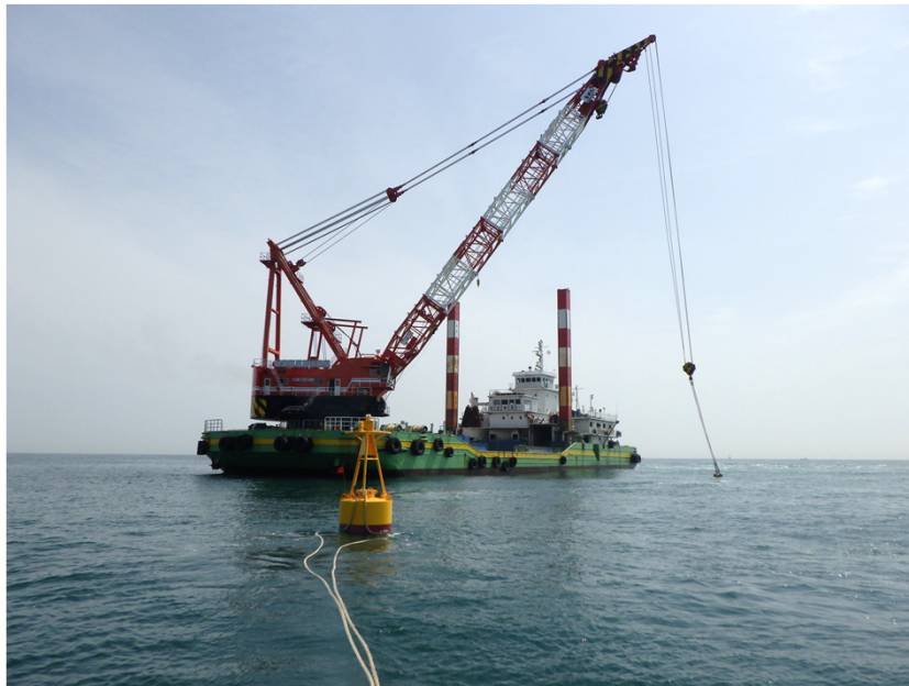
灯浮標の設置状況
