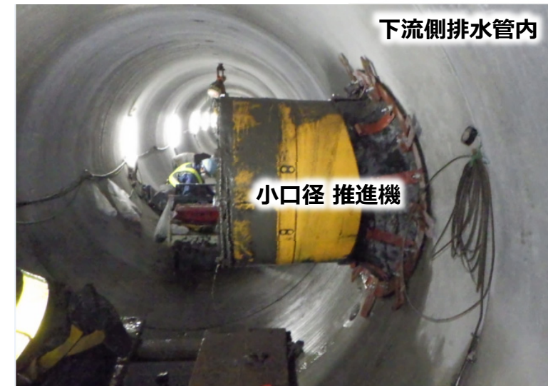
写真⑤ 小口径_本管接続
