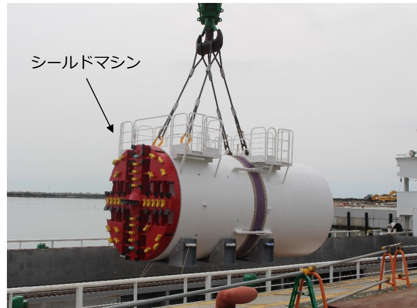
シールドマシン陸上げの状況
