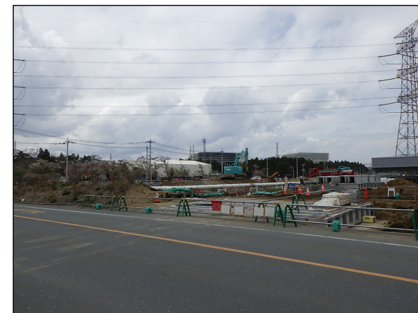
【配管移設（横断部）】撮影方向② (2022.4.18)
