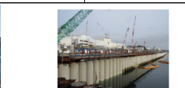
海側遮水壁打設完了の様子
