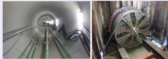
<①上流側推進管内部の状況> <②上流側推進管到達状況>
