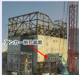
<現場状況（北西より）> (撮影：2022年4月12日)
