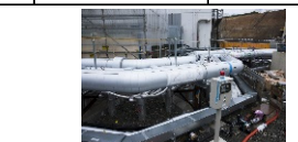
陸側遮水壁ライン（冷媒）循環配管
