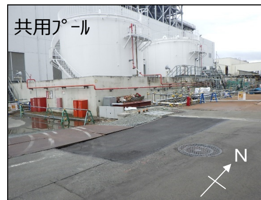
共用プール建屋大物搬入口前道路状況
