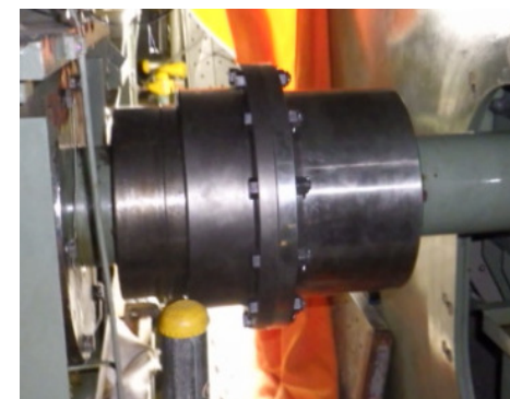
ギアカップリング交換後(塗装前)
