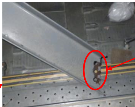
接合部のボルトが破断
