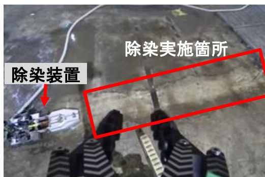
2号機原子炉建屋最上階の除染作業
