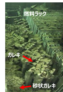
3号機プール中央のガレキ堆積状況
