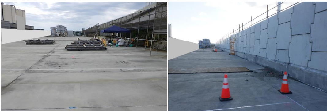
日本海溝津波防潮堤設置工事 (左：施工前、右：施工後)
