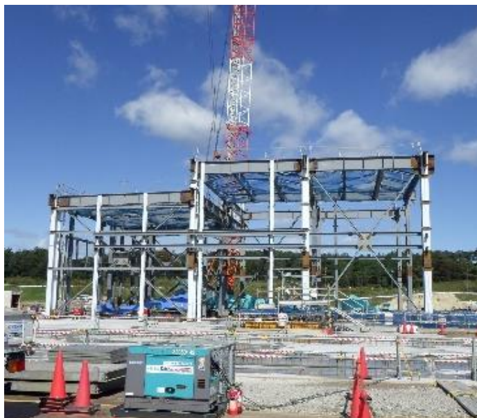
減容処理設備の建設状況 (2021年10月撮影)
