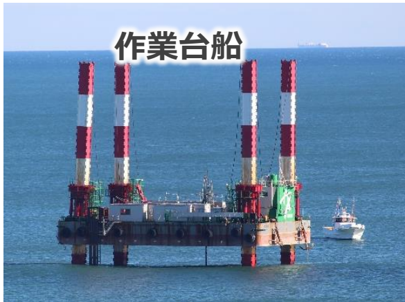
地質調査の状況
