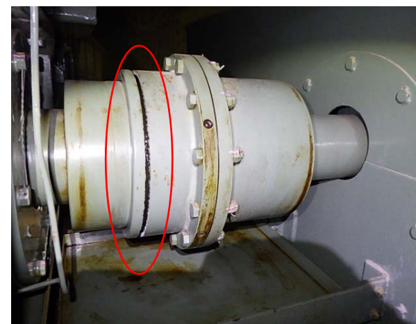
ギアカップリングカバー損傷部 3
