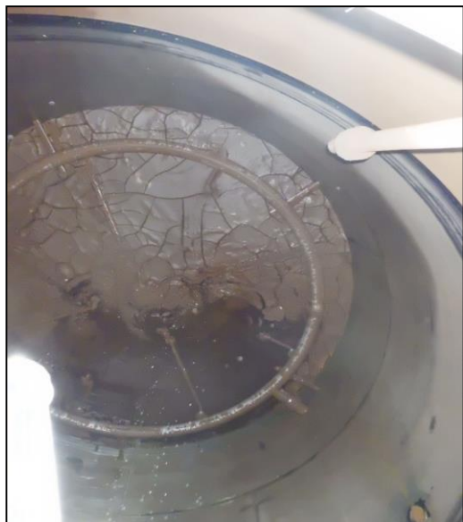
タンク内部（M/Hより撮影）
