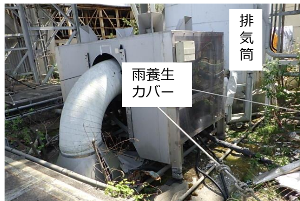
排気筒サンプ周辺状況
