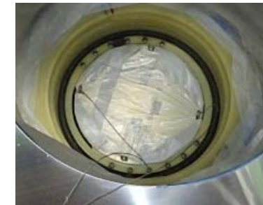
アルミ遮へい設置状況 (外周部に若干の隙間有り)
