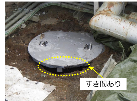
サンプ南東部のマンホール
