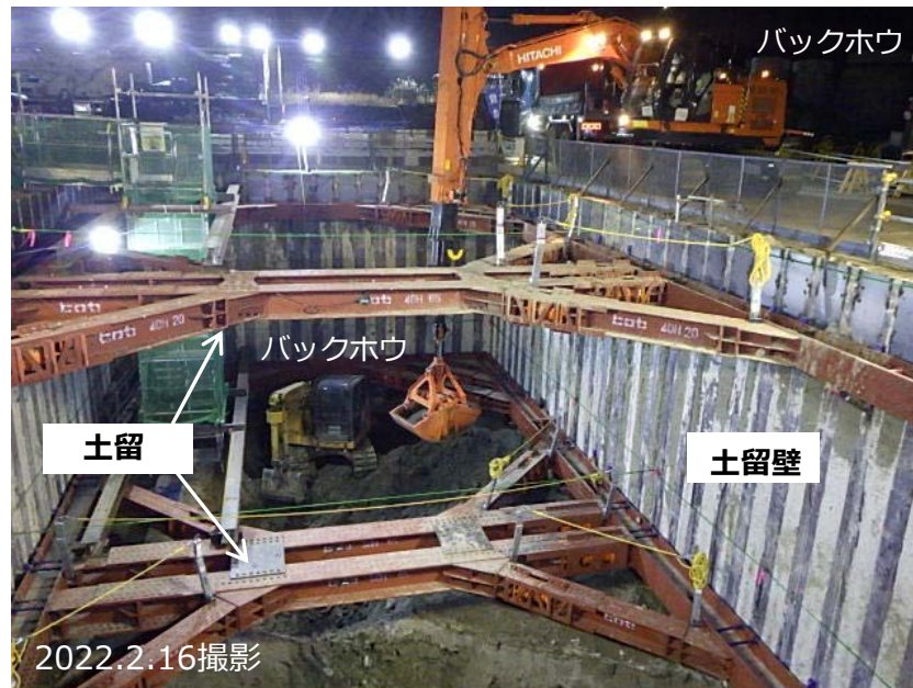
写真① 立坑掘削状況
