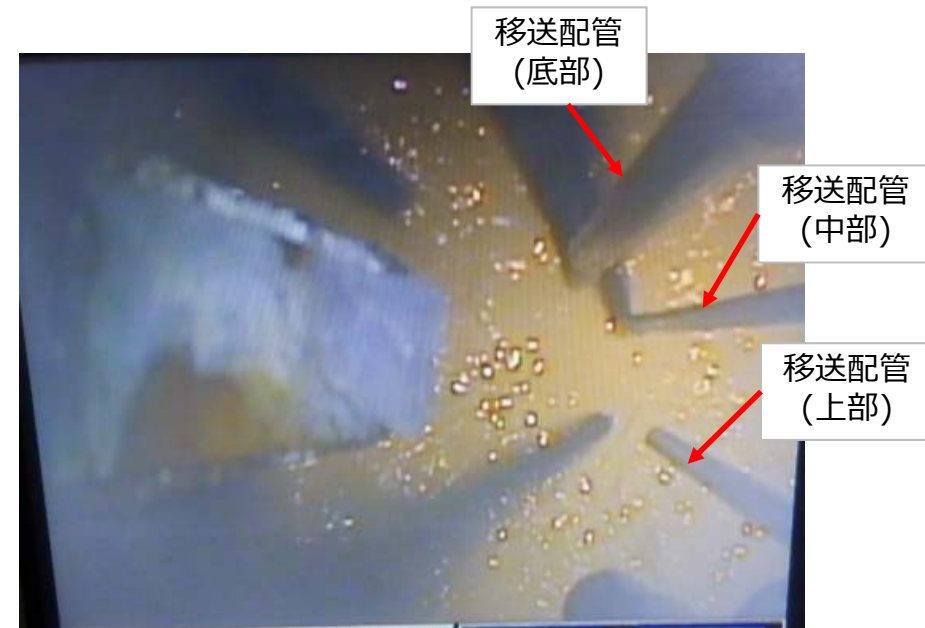
SEDS付属のカメラによるスラリー移送直後の 移替え元HIC内画像
