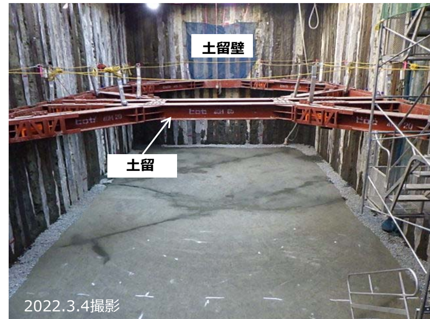
写真② 立坑掘削完了
