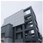
<4号機 燃料取り出し用カバー>
