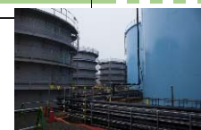
海側遮水壁打設完了の様子
