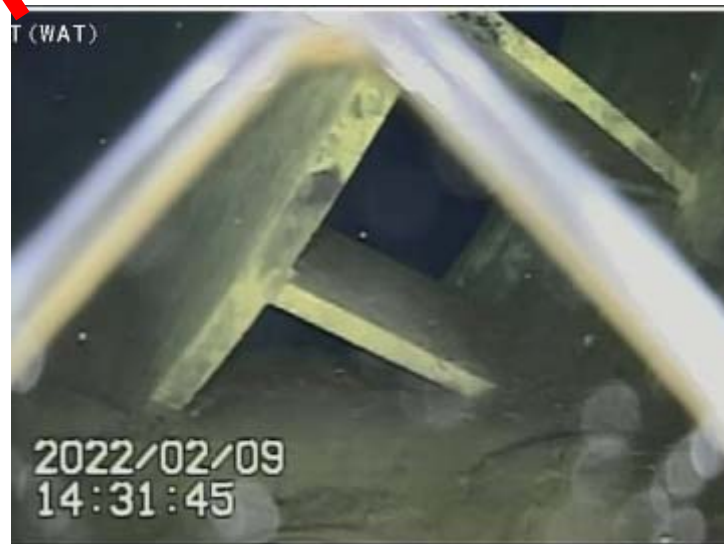
PCV東北東付近の状況 (近接)
