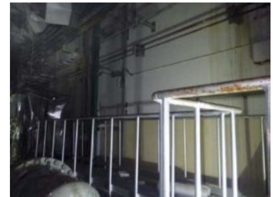
4階プール壁西面（写真）
