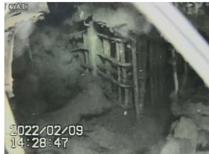
A. ペDESTAL開口部付近
