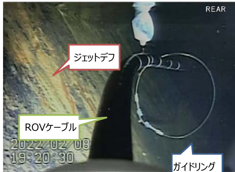
ガイドリング②設置状況（2月8日午後7時49分設置完了）
