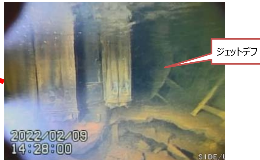
PCV東北東付近の状況(俯瞰)
