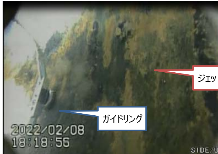
ガイドリング①設置状況（2月8日午後6時18分設置完了）
