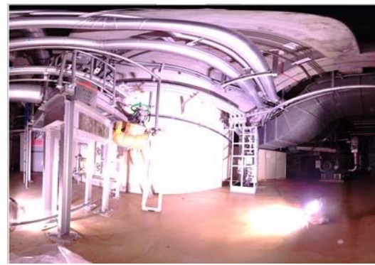
3階シェル壁北東面（写真）
