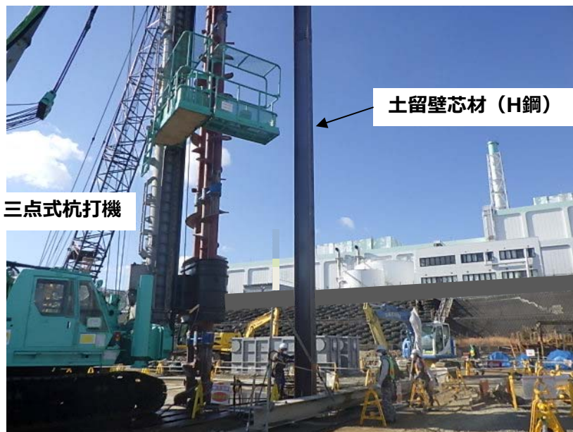
写真① 土留壁設置状況
