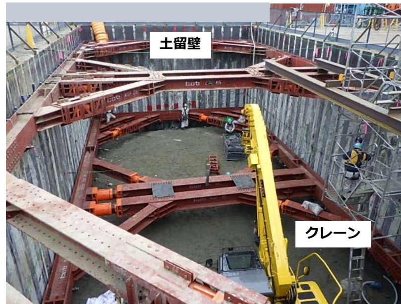
写真② 立坑掘削状況
