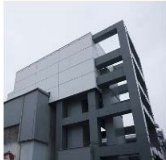
<4号機 燃料取り出し用カバー>
