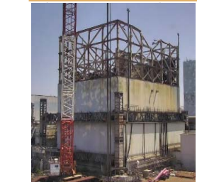
<1号機 残置カバー解体中の様子>
