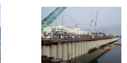
海側遮水壁打設完了の様子
