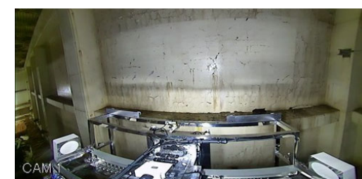
高所壁面除染後
