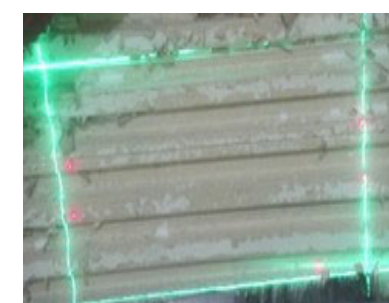
天井面除染後
