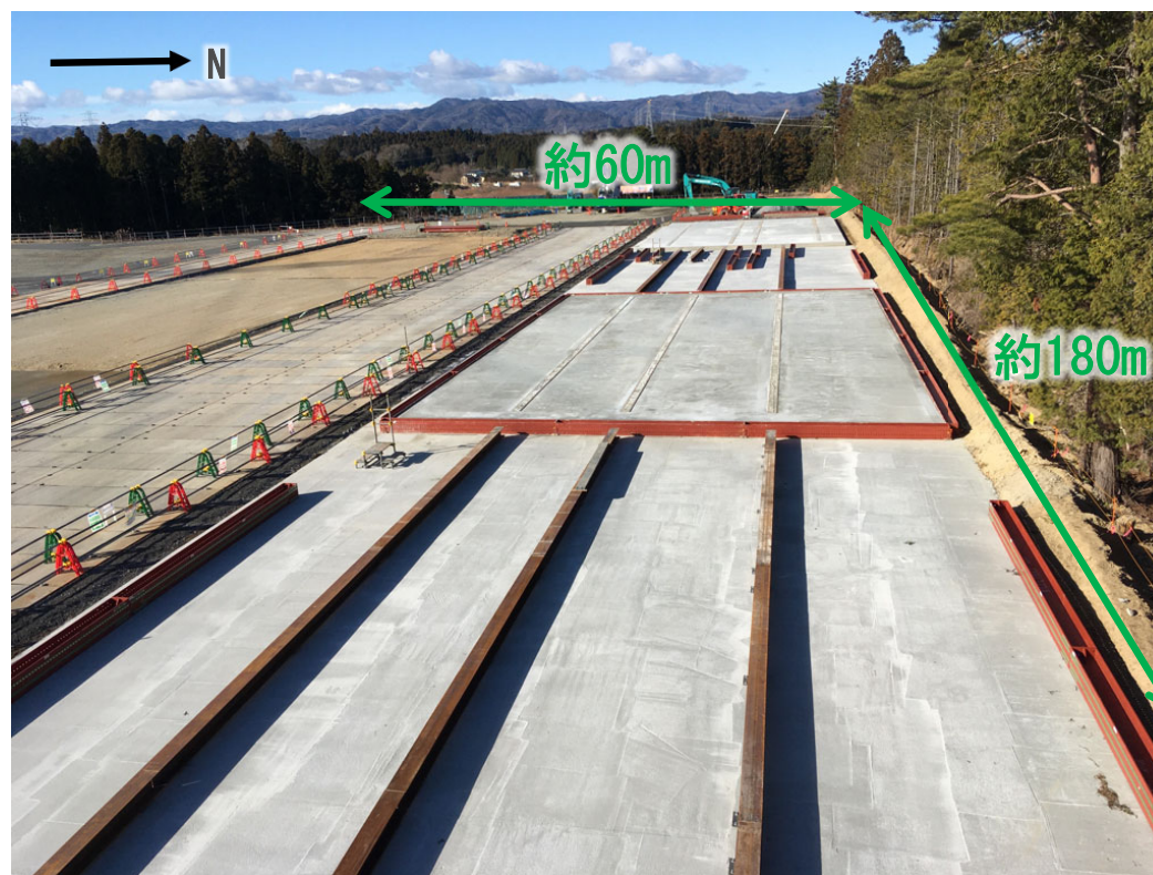
構外ヤード全景（撮影：2022.1.19）
