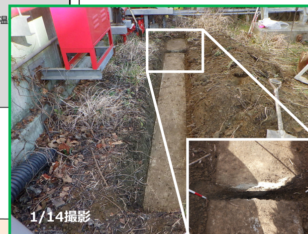
雨水排水設備（地下側溝）の損傷箇所
