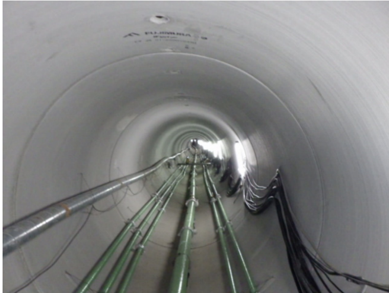
写真② 推進管直線部 免震棟南側直下
