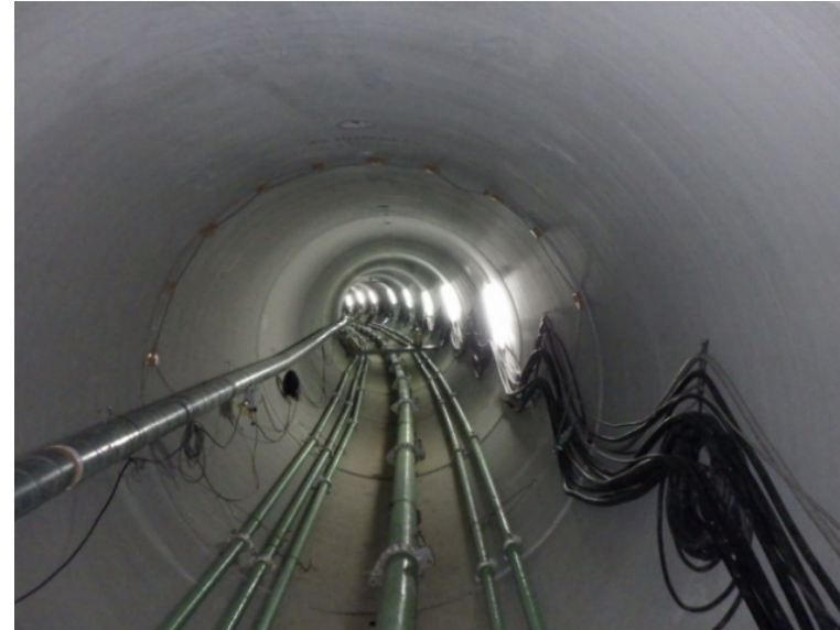
写真③ 推進管曲線部 事務本館南側直下
