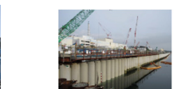
海側遮水壁打設完了の様子
