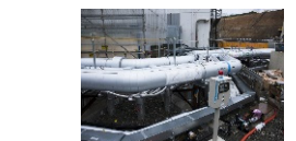
陸側遮水壁ライン（冷媒）循環配管
