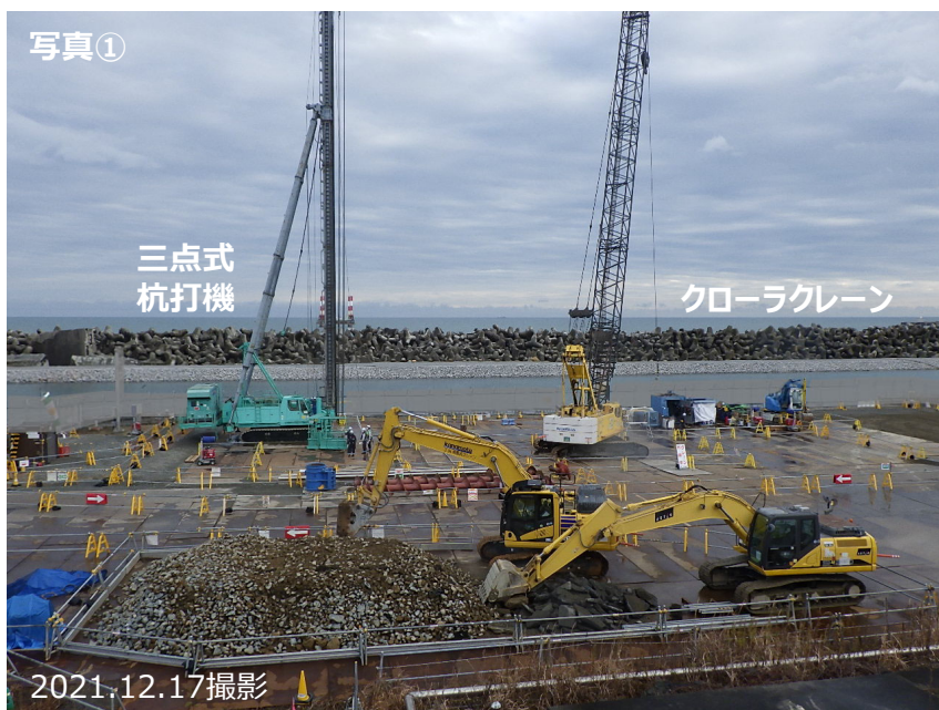
5・6号機取水口付近ヤード全景
