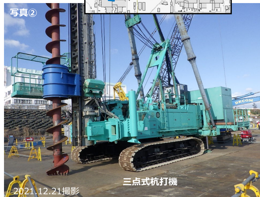
三点式杭打機
