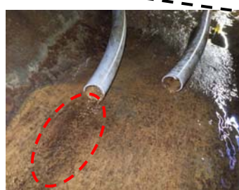
湧水箇所(導水パイプ)
