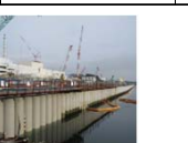
海側遮水壁打設完了の様子
