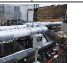
陸側遮水壁ライン（冷媒）循環配管
