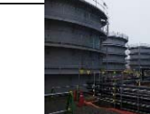
フランジタンク、溶接タンク
