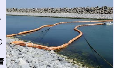
＜5・6号機取水路開渠シルトフェンス（既設）展張状況＞
