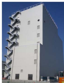
作業員の皆さまが休憩する大型休憩所を設置し、2015年5月より運用を開始。大型休憩所には、休憩スペースに加え、事務作業が出来るスペースや集合して作業前の安全確認が実施できるスペースを設けている。大型休憩所内において、2016年3月にコンビニエンスストアが開店、4月よりシャワー室が利用可能となった。
