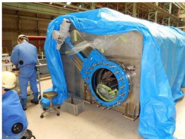
エンクロージャ養生除去作業状況
