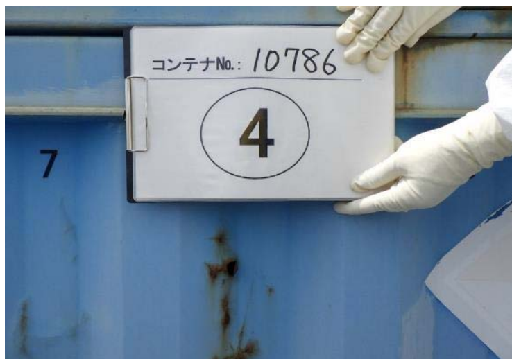
写真7.側面に著しい腐食があるコンテナ (貫通有るが水漏れ無し)(E1エリア, 5月3日撮影)
