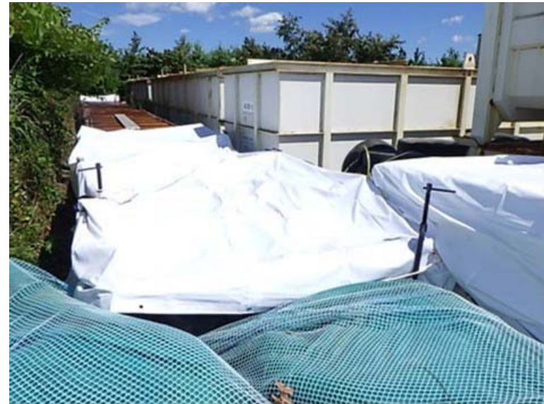
シート養生後
