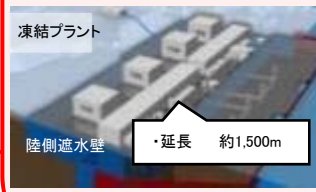
凍結プラント 陸側遮水壁 ・延長 約1,500m
