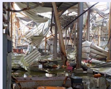
＜1号機廃棄物処理建屋の様子＞
