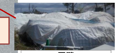
瓦礫（シート養生）
