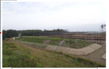
覆土式一時保管施設
