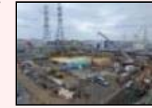
H1東エリア解体後の様子
