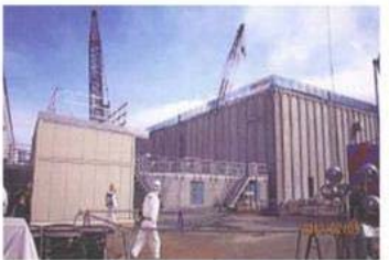
廃スラッジ一時保管施設
