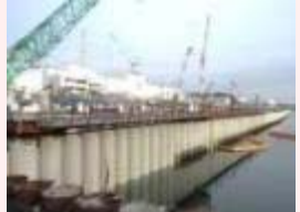
海側遮水壁 鋼管矢板打設完了状況
