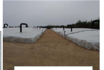
伐採木一時保管槽
