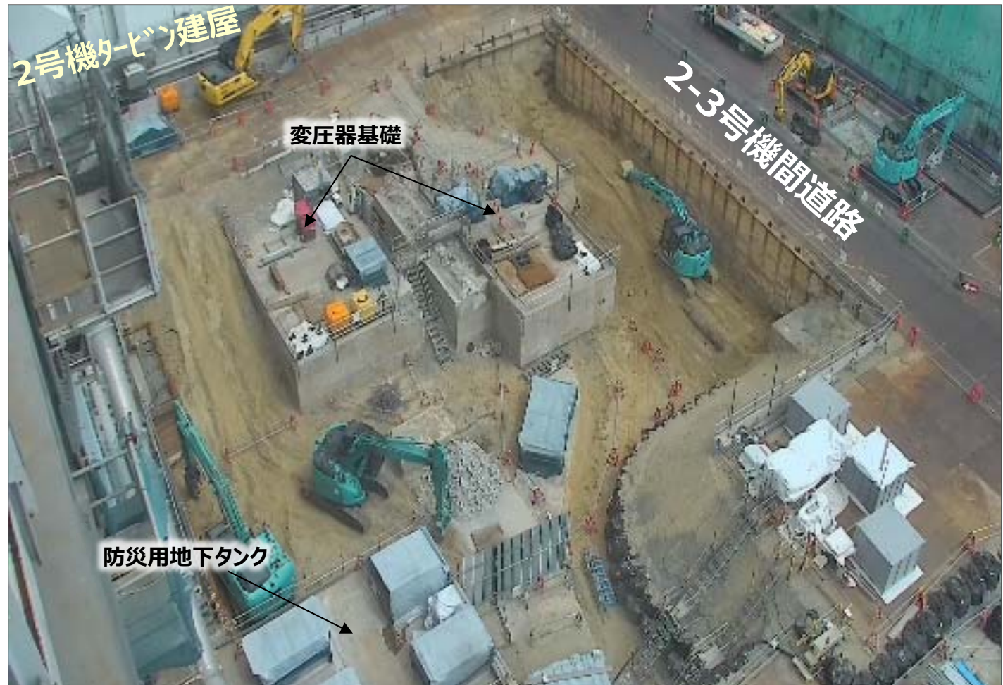
2号機原子炉建屋南側ヤード状況 (撮影日: 2021年5月29日)
