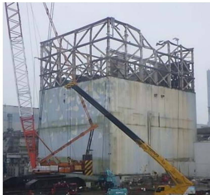
1号機原子炉建屋全景 (2021年6月19日時点)
