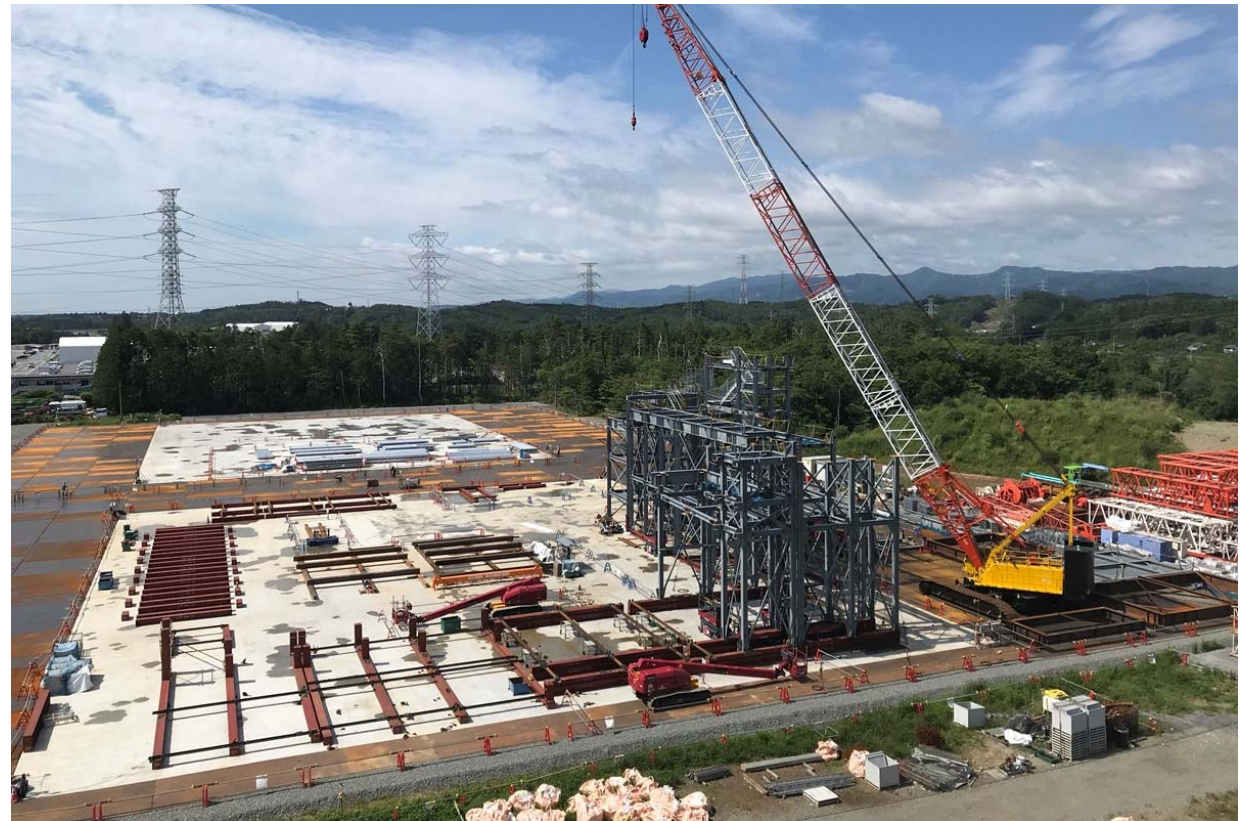
構外ヤード全景（2021年6月21日時点）
