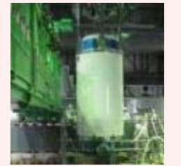
燃料取り出し状況
