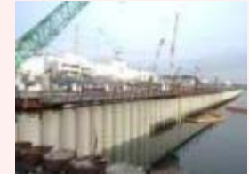
海側遮水壁 鋼管矢板打設完了状況
