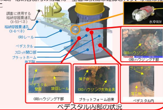
ベDESTAL内部の状況
