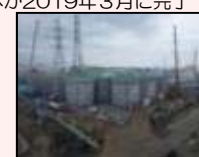
H1東エリア解体開始時の様子
