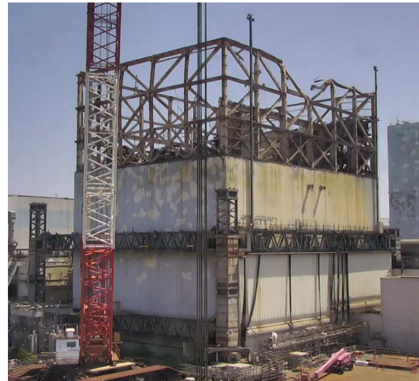
1号機原子炉建屋全景 (2021年4月22日時点)
