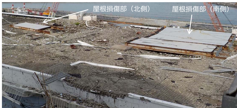
3号機タービン建屋・屋根状況【着手前】 〔西側から撮影〕
