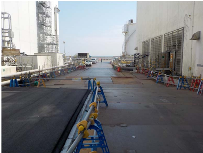
■ 2-3号間道路（海側） 状況写真 (施工前)
