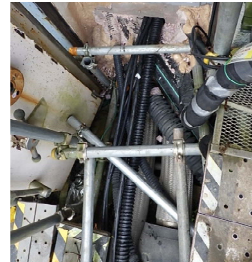
写真2：配管貫通部の状況例
