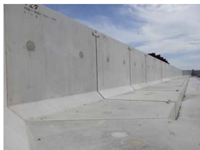
千島海溝津波防潮堤のL型擁壁
