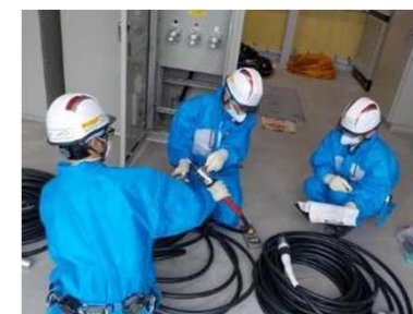
ケーブル導通訓練
