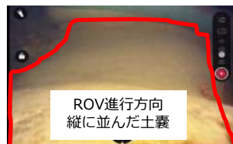
PMBの土嚢状態(現在)
