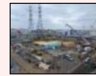
H1東エリア解体後の様子
