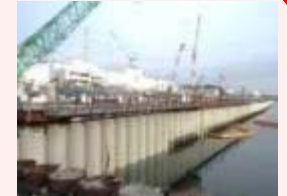
海側遮水壁 鋼管矢板打設完了状況
