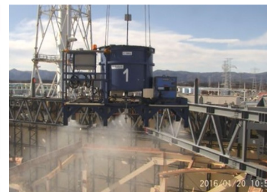
飛散防止剤散布状況
