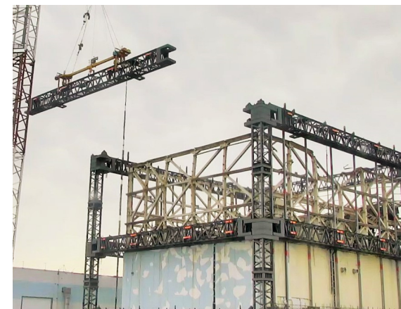
上部解体時の梁取り外し状況 撮影：2017.7
