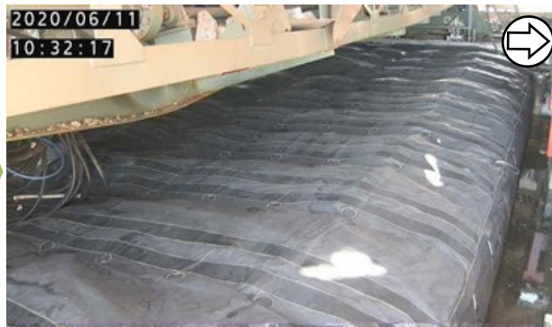
エアモルタル充填 (撮影日: 2020.6.11)
