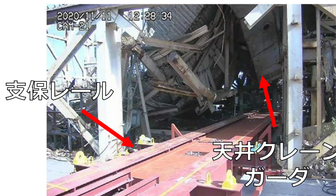
I. 支保レール設置完了 (撮影日: 2020.11.11)
