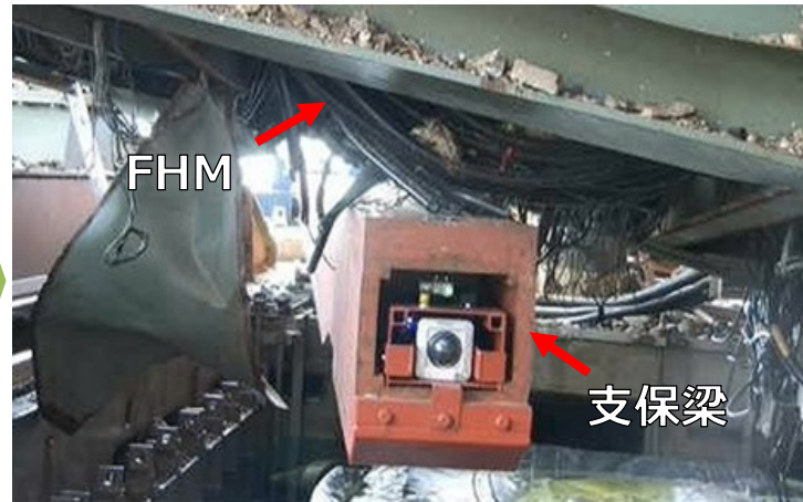
II-a. 支保梁挿入中 (撮影日：2020.10.20)
