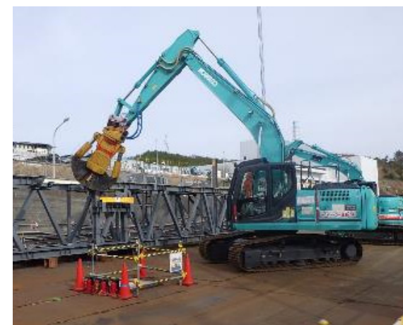
上部解体時の小割解体状況 撮影：2017.4
