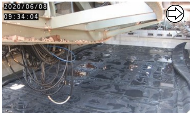
養生バッグ展張 (撮影日: 2020.6.8)
