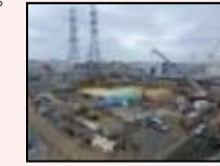
H1東エリア解体後の様子
