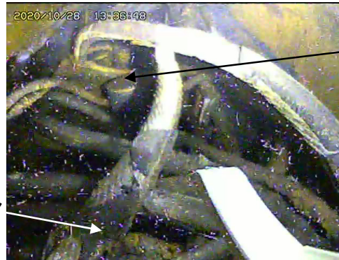
③ケーブル及びくり抜き部の状況
