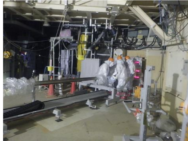
X-6ペネ前での調査装置設置作業
