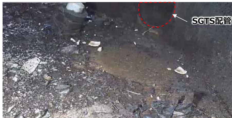
写真：SGTS配管状況（5/20雨天時）
