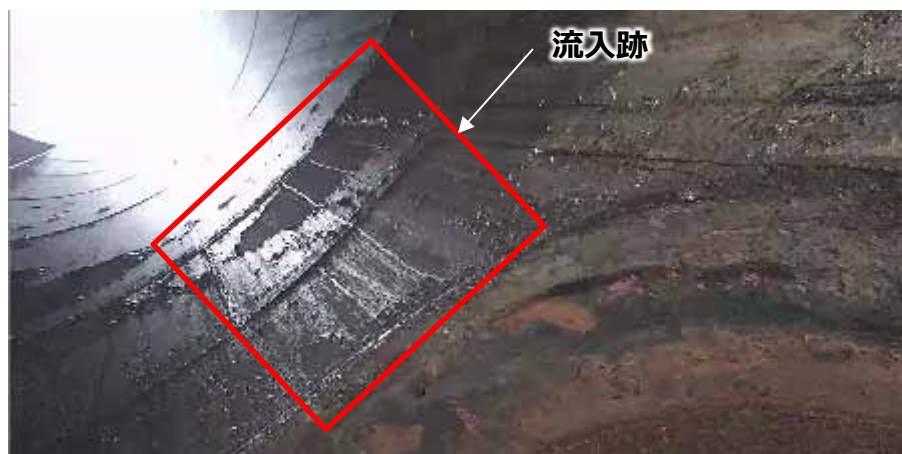
写真：排気筒内面状況（5/20雨天時）
