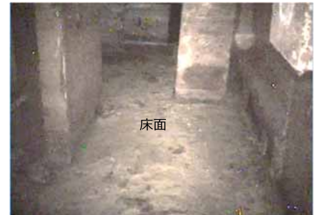
3号機タービン建屋 サービスエリア最下階床面
