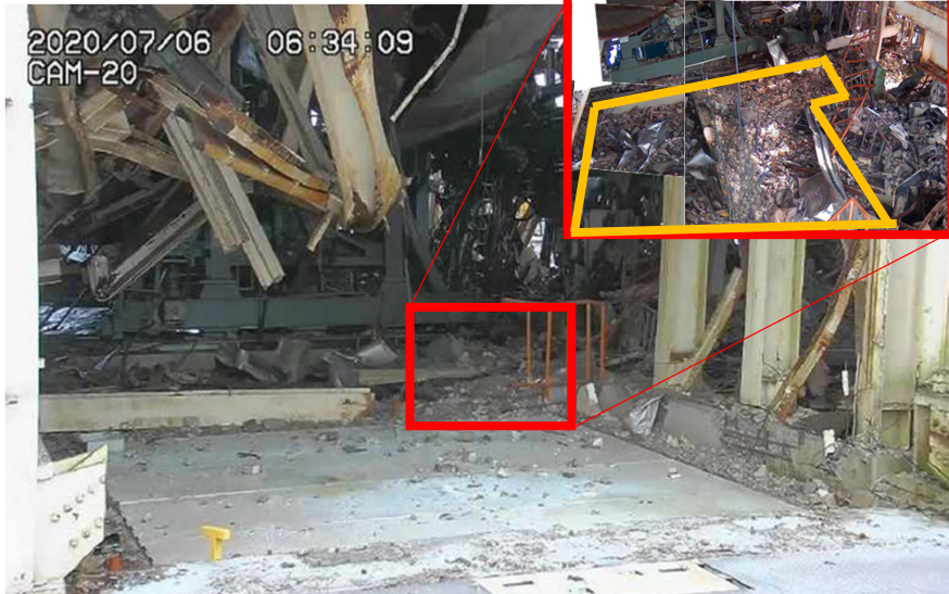
ガレキ撤去前(撮影日:2020.7.6)
