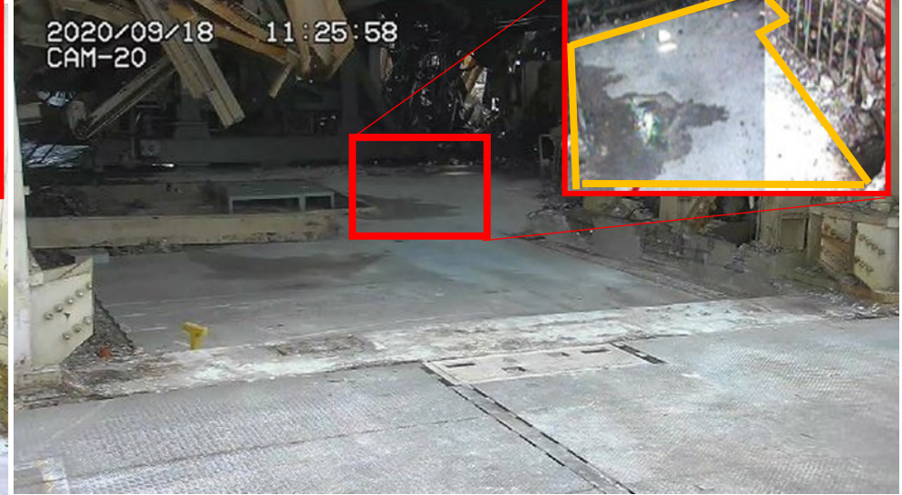
ガレキ撤去後(撮影日:2020.9.18)
