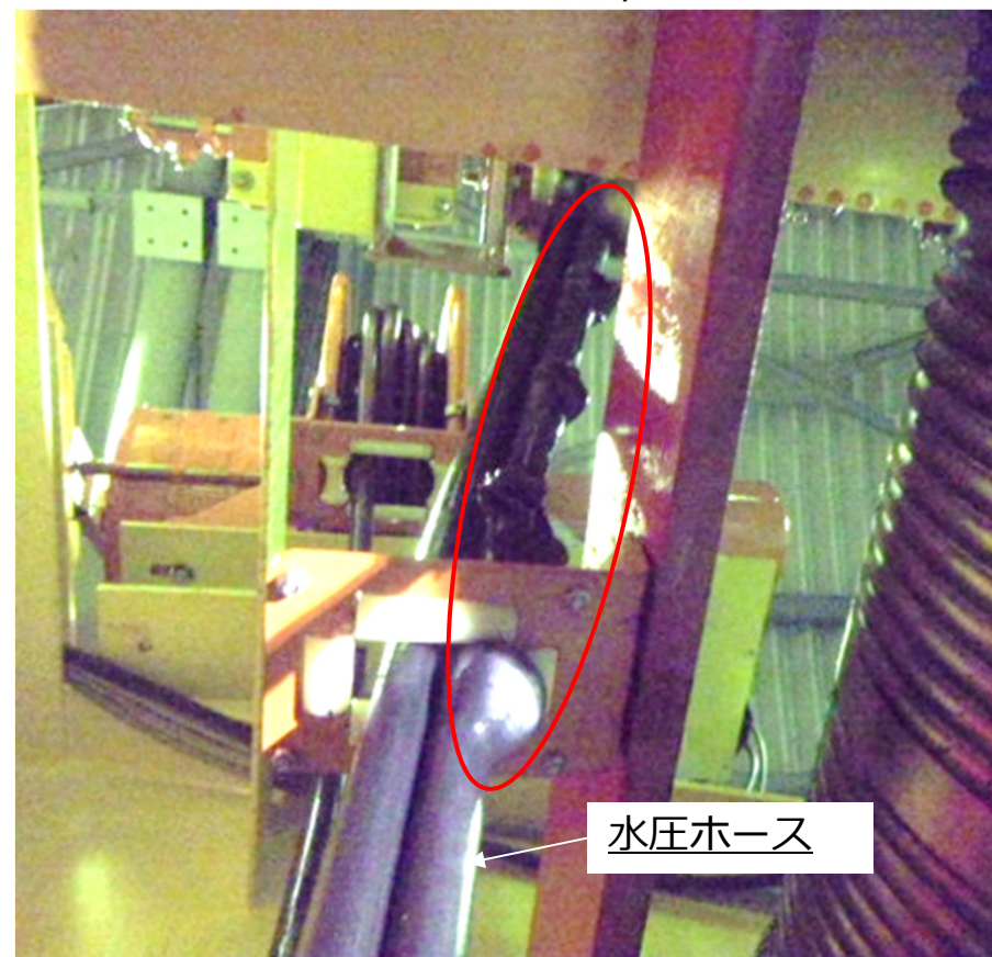
水圧ホースの状況
