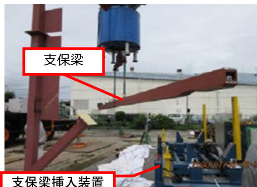
①支保梁挿入装置への支保梁搭載
