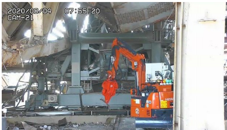
ガレキ撤去作業(撮影日:2020.8.4)
