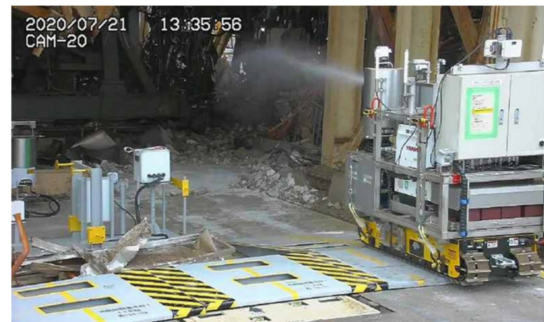
飛散防止剤散布(撮影日:2020.7.21)
