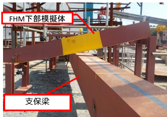
②支保梁挿入
