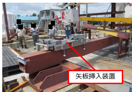
④矢板挿入装置の支保梁への設定
