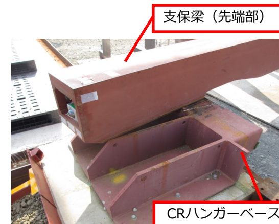
③支保梁挿入 (完了)
