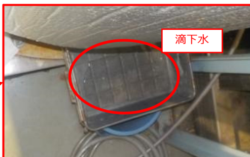
現場状況 (写真)
